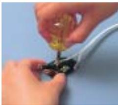
2号のドライバーでしっかりねじを締める。ねじが軽く締まってから1/3以上ねじが空回りするまでしっかり締める。
